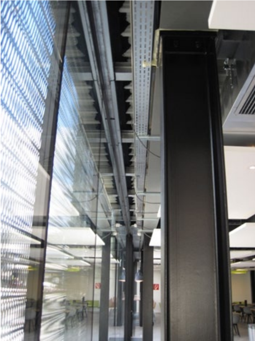
Détail de la façade vitrée.
