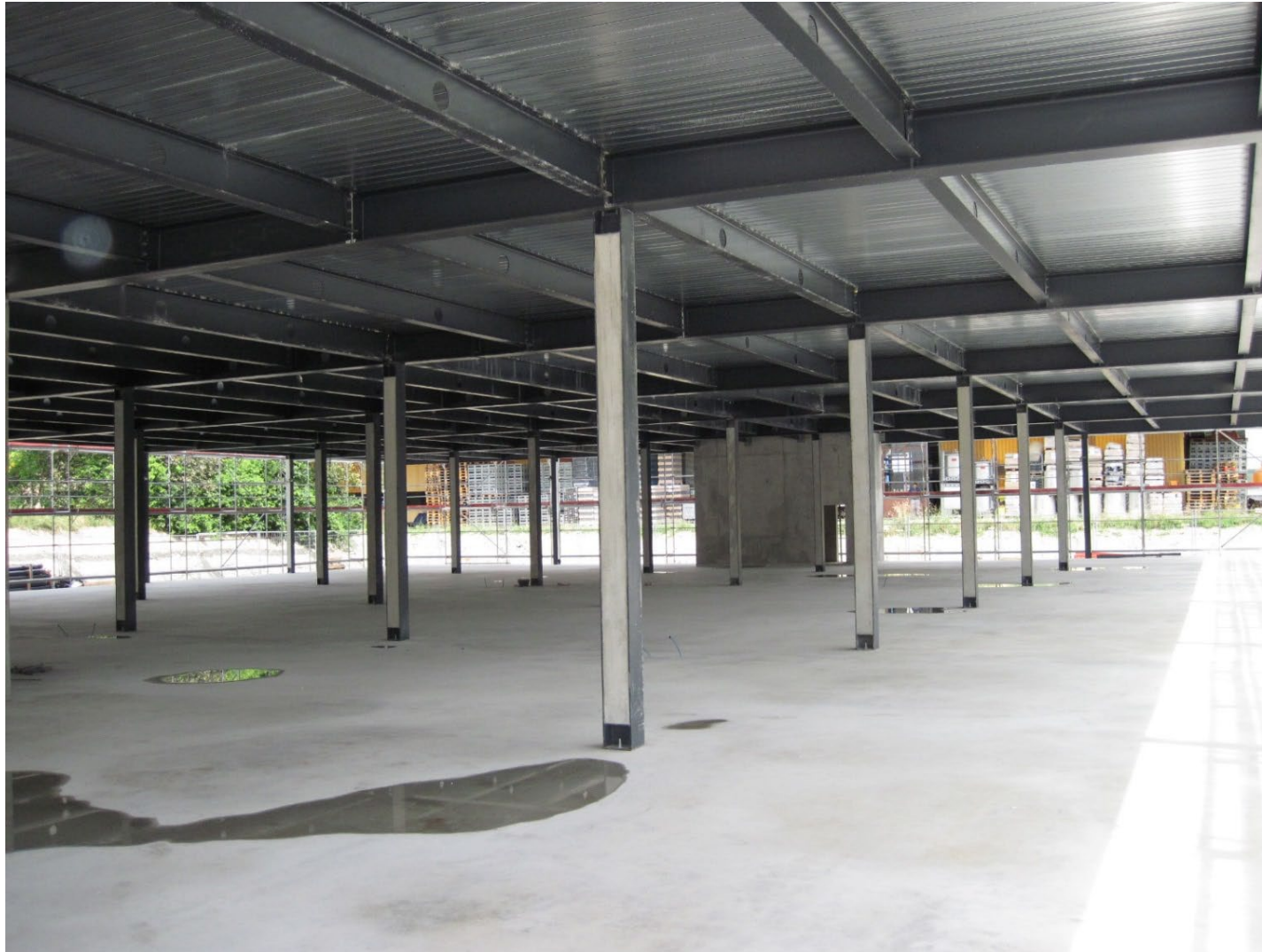
Halles multi activités à Puidoux
