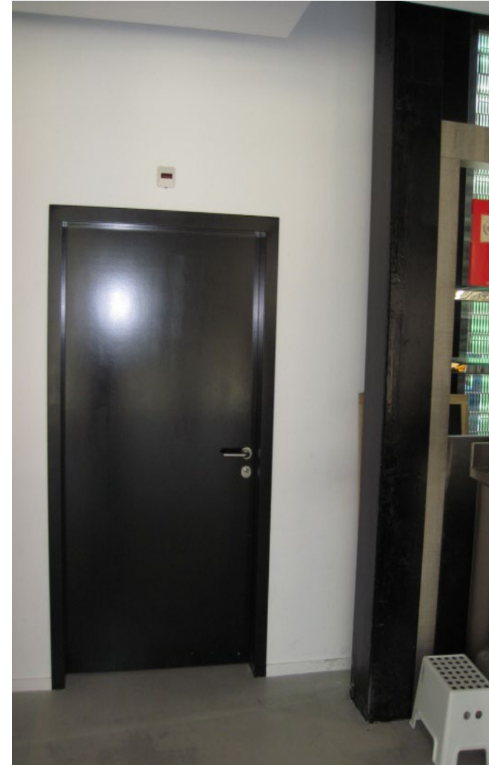
Poteau HEB 240 caissonné axe CS-08.
